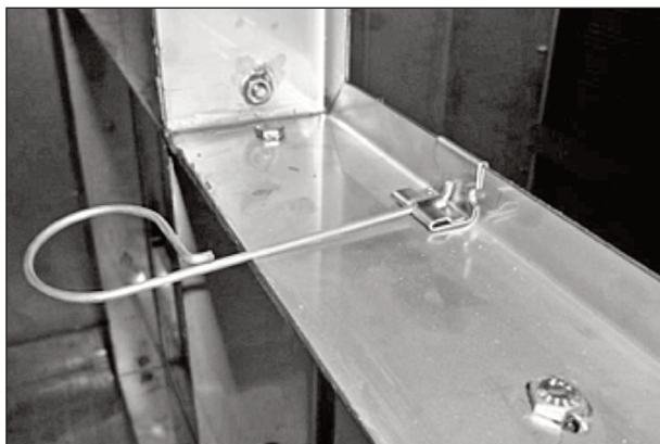
Instalación de pinza para prefiltros de 4" MERV 8-10
