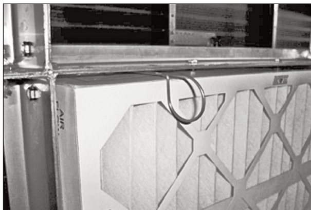
Instalación de pinza para prefiltros de 4" MERV 8-10
