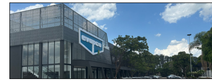
EVAPCO Brasil Equipamentos Industriais Ltda., São Paulo, Brazil
