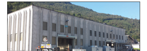
EVAPCO Europe, S.r.l., Sondrio, Italy
